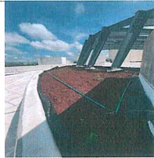
Estado Actual Nivel Azotea
