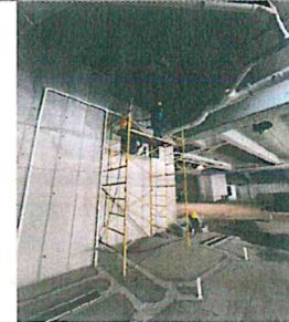
Estado Actual Nivel Galerías
